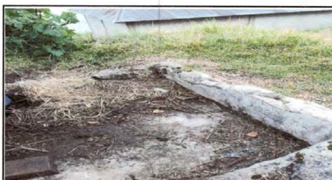
Foto 4: Instalación de pila 1'2 M2
