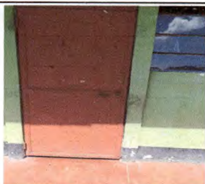
Foto 9: Sustitucion de puertas 1 metro de ancho * 2.70 centímetros de alto
