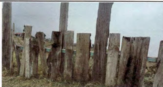
Foto 1: Reparación de tubo hg de 2plg y malla galvanizada 2m de alto y concreto
