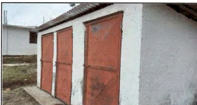
Foto 3: Sustitución de puertas en servicio sanitario 80 cm ancho * 2 metros de alto
