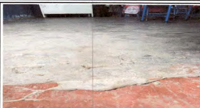
Foto 8: Sustitucion de piso de cemento liquido por concreto
