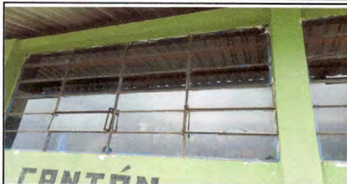
Foto7: Sustitucion de estructura de metal de ventana por PVC mas vidrio
