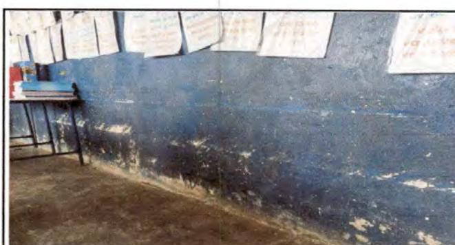
Foto 6: Pintura en Muros Exteriores e Interiores
